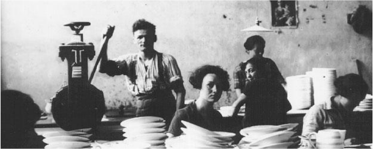
Operai al lavoro
